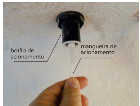
Figura 9 – ligação do acionamento pneumático
