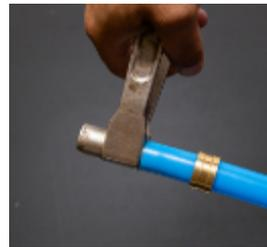
**2)** Inserir o anel e alargar a extremidade do tubo com o alargador de tubos. O alargamento deverá ser realizado gradualmente, girando o alargador e expandindo progressivamente a ponta do tubo.
