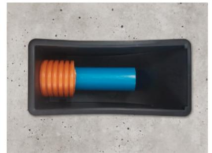
**3)** Após a concretagem e retirada da forma passe a tubulação de hidráulica pelo eletroduto.
