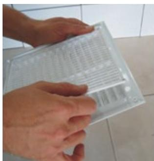
6) Faça o encaixe da tela anti-inseto na grelha, quando utilizado o modelo GV20/CT.
